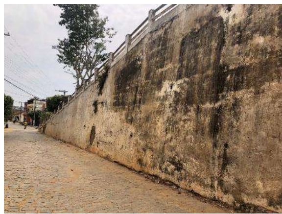
Figura 27. Muro de arrimo da Rua Juliano Lauer, que passa acima; e pavimentação de pedra da Rua Antônio Afonso Ferreira. IMAGEM: Bárbara Carmo, set/2022.
