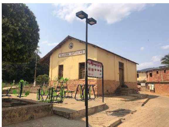
Figura 46. Vista do edifício da Estação Ferroviária de Silveira Carvalho, com equipamentos de ginástica na área em frente. IMAGEM: Bárbara Carmo, set/2022.
