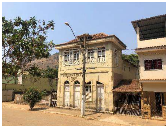
Figura 25. Antiga Pharmácia Globo com fachadas preservadas, na Praça Artur Duarte. IMAGEM: Bárbara Carmo, set/2022.
